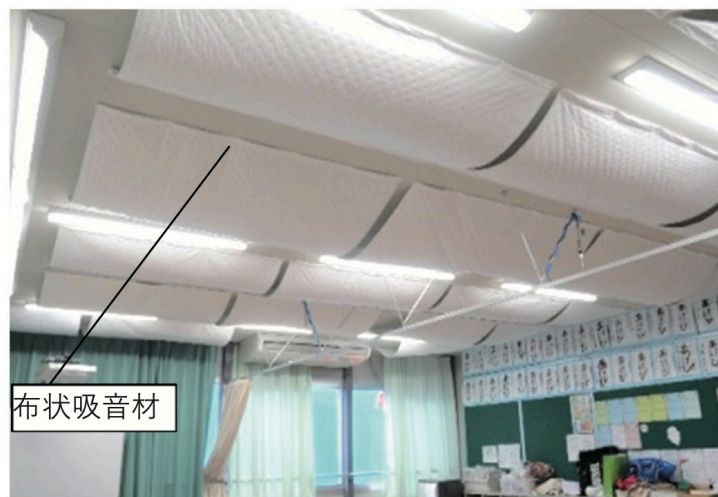
図8 吸音材設置後の様子
