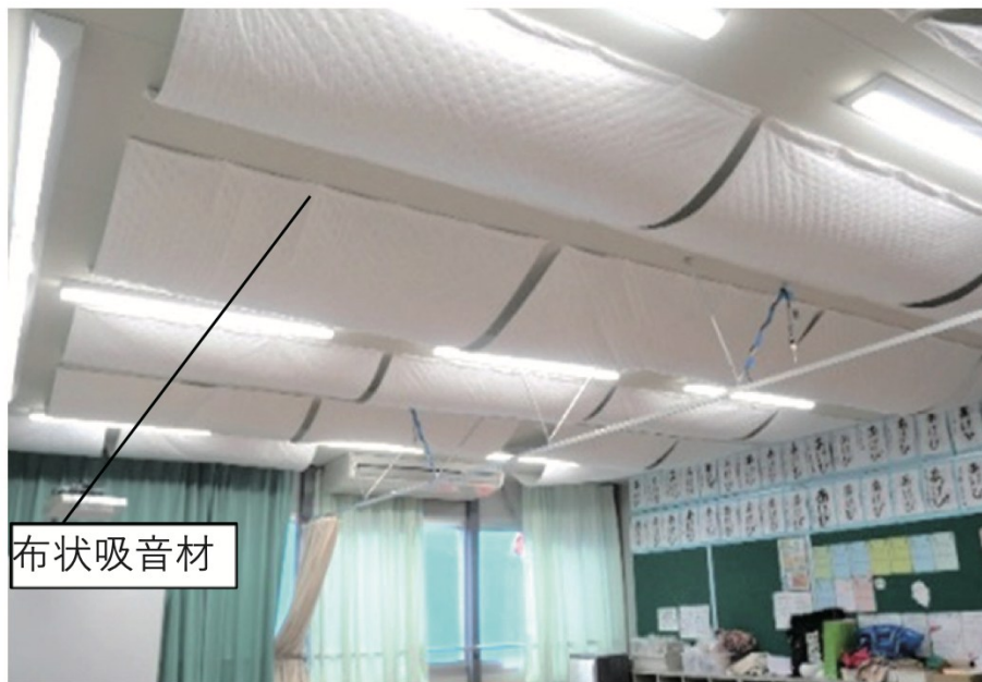
図 8 吸音材設置後の様子
